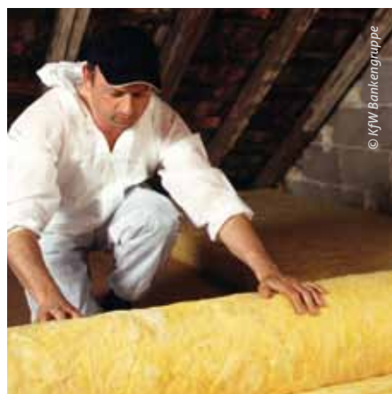
KfW-Zuschüsse für Einzelmaßnahmen begünstigen auch die Wärmedämmung
